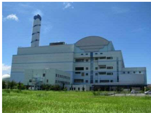
【皇后崎工場（廃棄物発電施設）】
